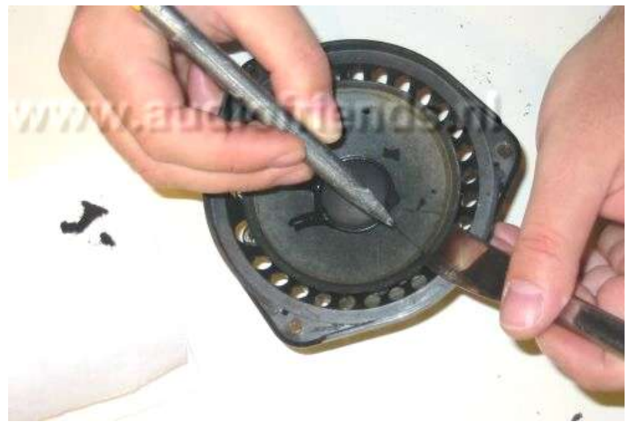
12. Is de conus minder dik en stevig, gebruik dan een boterhammes als ondersteuning.
